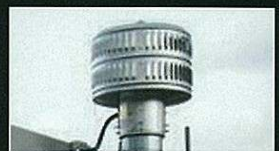
強制換気ベンチレーター
